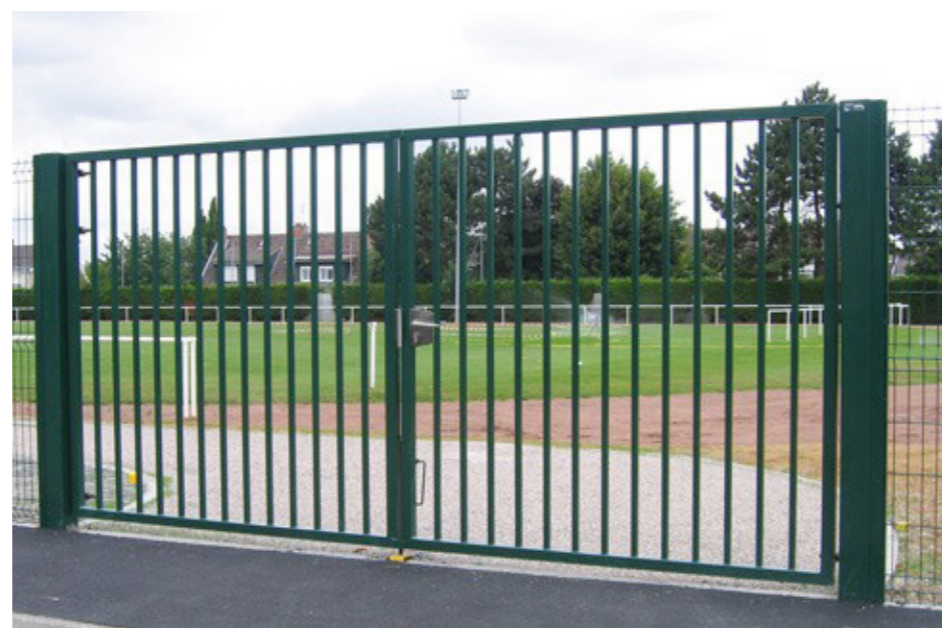
Portail d'accès au site
