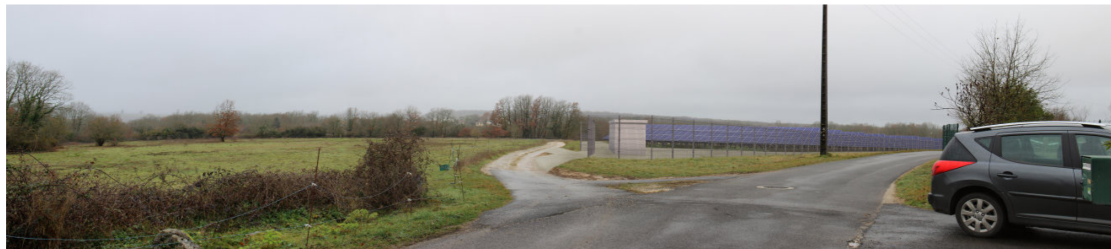
Vue 2: Vue de l'entrée du parc 7 au Sud de la centrale solaire depuis le chemin de la croix ronde (projet sans haie).
