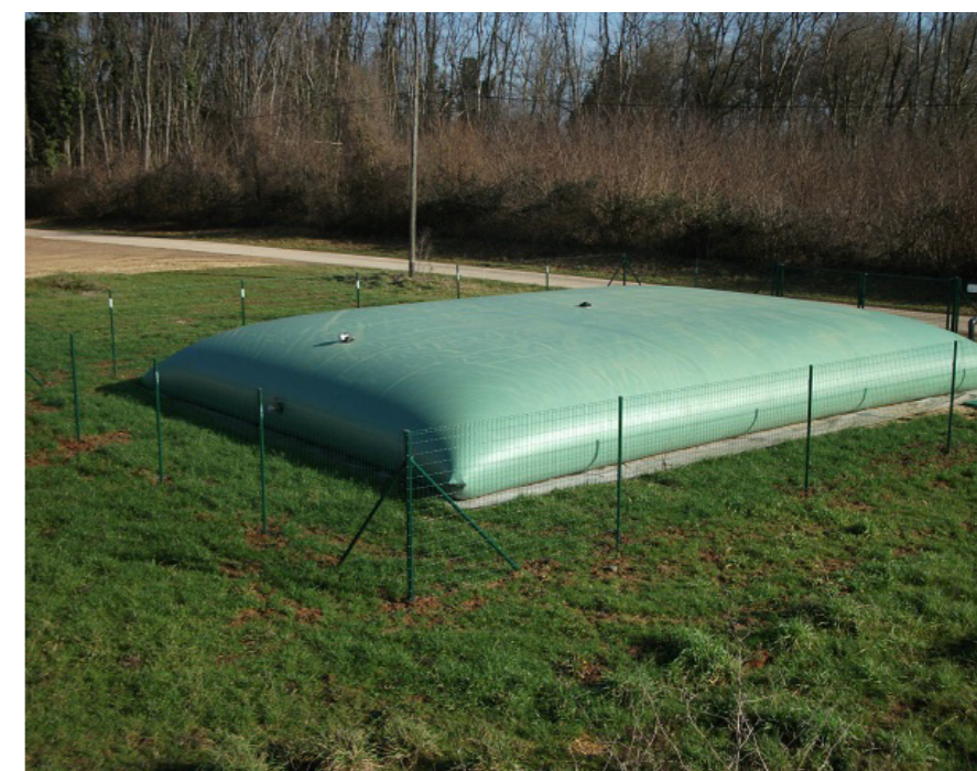
Citernes à eau: - 8 x 60m 3 pour les services incendie.
