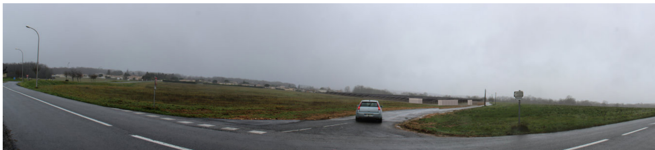
Vue 1: Vue de l'entrée du parc 1 à l'Est de la centrale solaire depuis la D 35 (projet sans haie).
